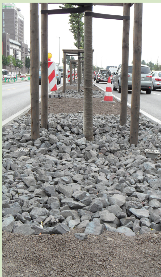
„Schotterbäume“ mit Kupferhüttenschlacke
