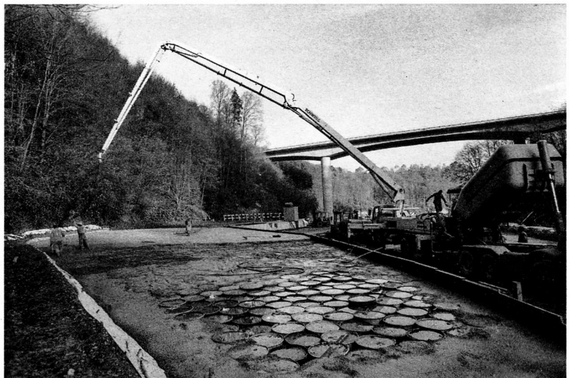
Einbetonieren einer Lage von Fässern mit hochgiftigen Abfällen und Produktionsrückständen (Dioxine, Insektizide, Schwermetalle) der Basler Chemie in Teufthal bei Mühleberg BE 1987. Sie lagern dort noch immer. Altlastenexperte Marco Buser (2019): "Es ist eine Frage der Zeit, bis der umhüllende Beton so stark angegriffen ist, dass er durchlässig wird und die Schadstoffe ins Grundwasser gelangen."
